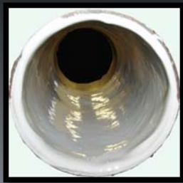
uusi, valettu putki
